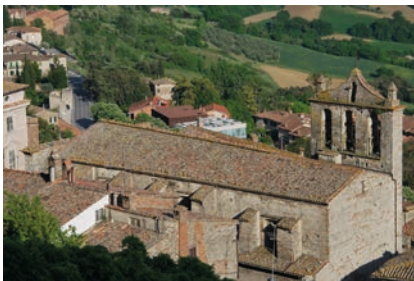
Vista della copertura da San Fortunato
