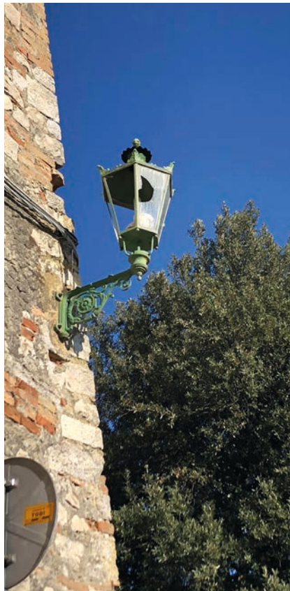
Rotto da anni, all'imbocco delle Piaggiole
